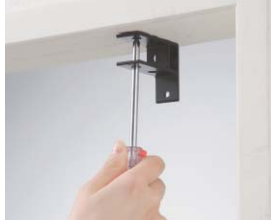
窓枠の内側に取付ける場合(天井付け)
